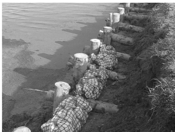
**Figura 7.15 – Esempio di intervento di stabilizzazione con pali infissi sul piede della sponda e burghe di consolidamento (da completare con il riempimento e la riprofilatura della sponda)**
