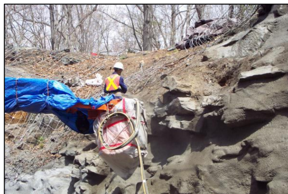
Fig. 95 – Utilizzo di cemento proiettato per la stabilizzazione di pareti rocciose; l'immagine di destra è tratta dal sito internet www.dot.state.co.us (Colorado Department of Transportation), quella di sinistra dal sito www.janod.biz (Janod Inc.).
