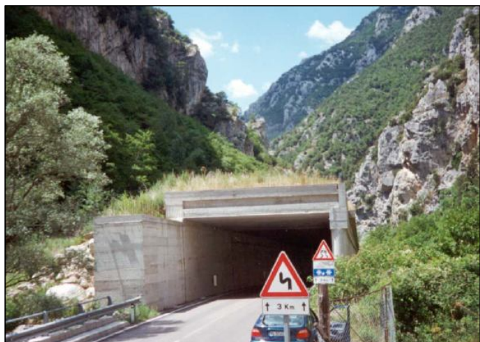
Fig. 127 – Galleria paramassi realizzata a protezione di un tratto stradale; si può notare il materiale detritico posto sulla volta e sul lato di monte (a sinistra) con lo scopo sia di attutire l’impatto dei blocchi che di mitigare il vistoso impatto ambientale della struttura, favorendo lo sviluppo di vegetazione a crescita spontanea.
