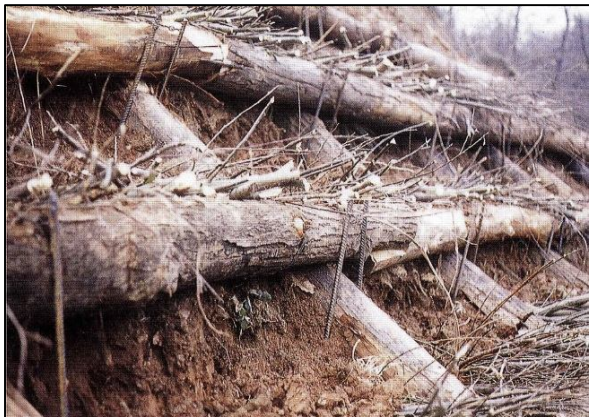
Fig. 32 – In alto rappresentazione schematica di una grata viva. In basso un intervento di stabilizzazione di una frana da scivolamento effettuato tramite la realizzazione di una grata viva: a sinistra particolare della struttura e delle talee di salici; a destra opera a sei mesi dall'ultimazione (da REGIONE LIGURIA, 1997).
