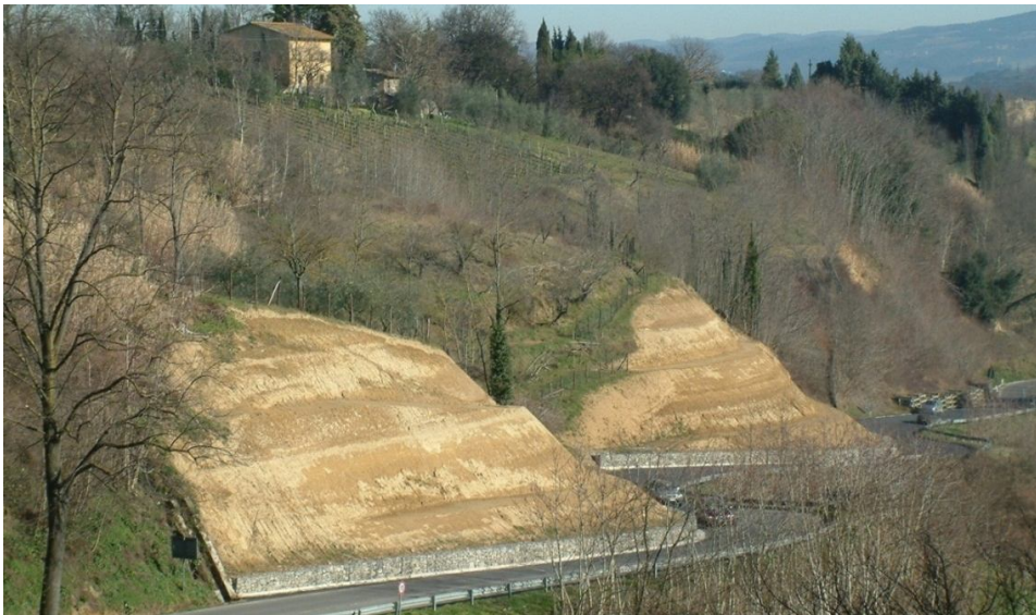
Fig. 10 - Stabilizzazione di un versante tramite intervento di gradonatura.
