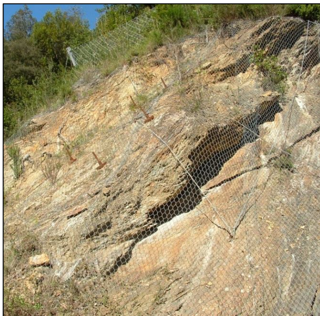
Fig. 121 – A sinistra rivestimento provvisorio, tramite rete esagonale a doppia torsione, di una sponda rocciosa di un corso d'acqua. A destra stabilizzazione di una scarpata rocciosa tramite rete esagonale a doppia torsione rinforzata con un reticolo di funi in acciaio e bullonature.
