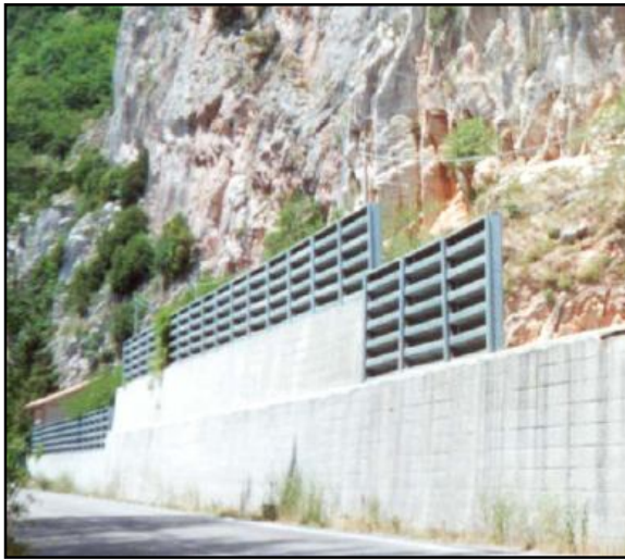
Fig. 124 – A sinistra barriera paramassi rigida in cemento armato sormontata, nei tratti più critici, da una barriera deformabile in pannelli metallici prefabbricati. Nel caso specifico, questo tipo di intervento è accoppiato al rivestimento della parete rocciosa retrostante con rete metallica (da ANPA 2002). A destra barriera rigida, costituita da pannelli in legname incastrati su travi metalliche a doppio T, per il controllo di crolli di materiale detritico in legname.
