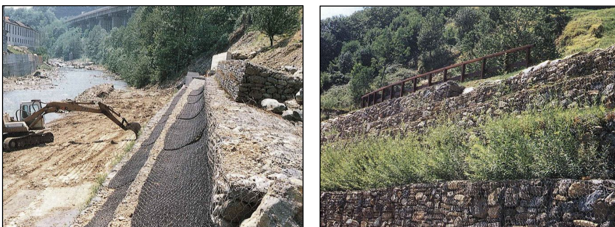
Fig. 62 – Utilizzo di gabbioni nella stabilizzazione della sponda sinistra di un torrente. Successivamente alla realizzazione della gabbionata, sono state messe in posa delle talee di salice (tra la pedata e l'alzata della gradonatura) ricoperte con terreno protetto con materiale geosintetico (geostuoia, vedi interventi B1a); la fascinata di talee è stata poi ancorata alla gabbionata tramite una rete metallica a maglia esagonale. A sinistra fase di realizzazione dell'opera, a destra opera a sei mesi dal completamento (da REGIONE LIGURIA, 1997).
