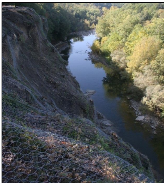
Fig. 121 – A sinistra rivestimento provvisorio, tramite rete esagonale a doppia torsione, di una sponda rocciosa di un corso d'acqua. A destra stabilizzazione di una scarpata rocciosa tramite rete esagonale a doppia torsione rinforzata con un reticolo di funi in acciaio e bullonature.
