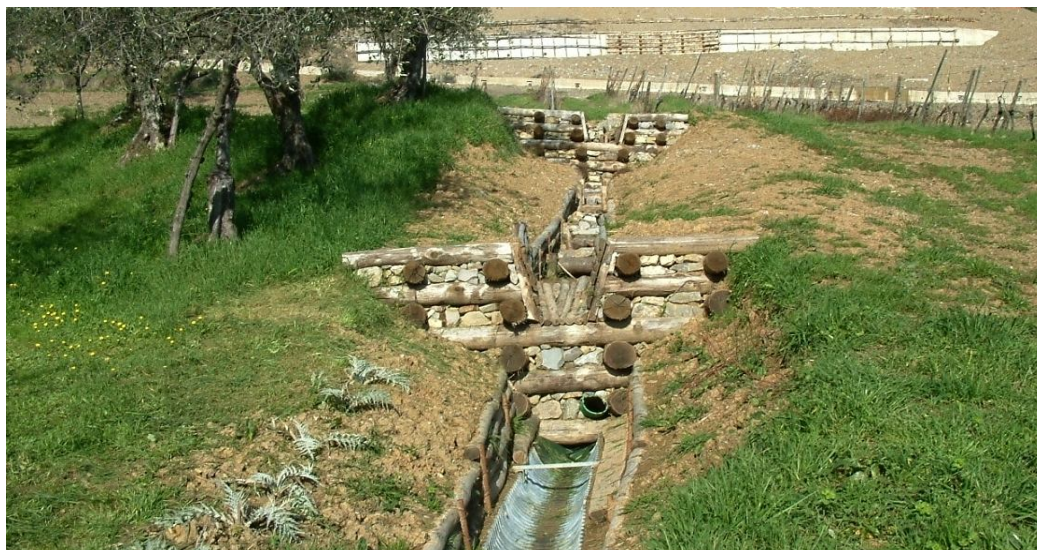
Fig. 36 – Consolidamento di un versante tramite un sistema di canalette superficiali in legname-pietrame nella porzione superiore e in lamiera nella porzione inferiore.
