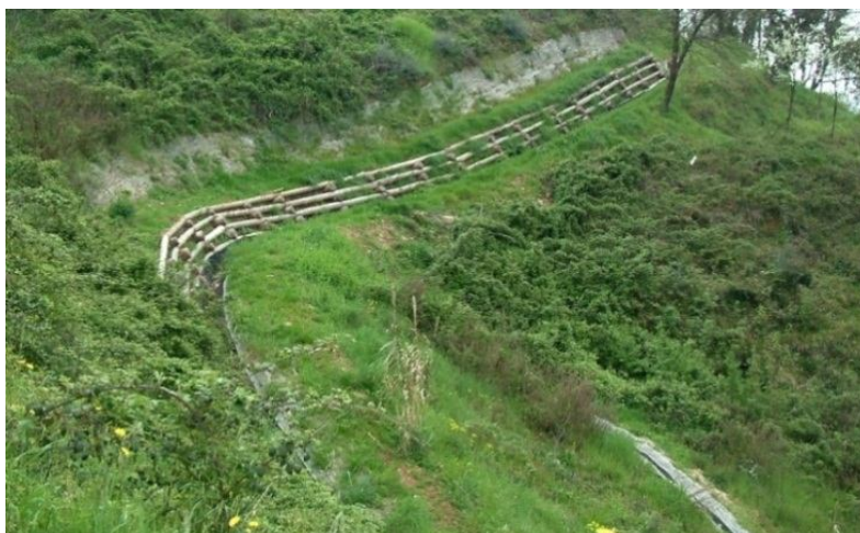
Fig. 29 – Utilizzo di palificate nella stabilizzazione di un versante. La stabilizzazione è completa tramite rivestimento con biostuoie (B1b) e rinverdimento (B1c).
