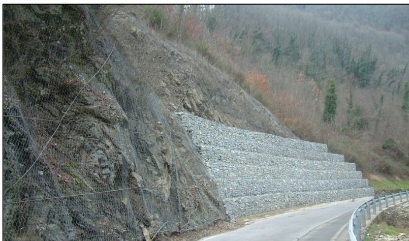
Fig. 63 - Stabilizzazione di una scarpata rocciosa tramite gabbionata e rete metallica a maglia esagonale a doppia torsione.
