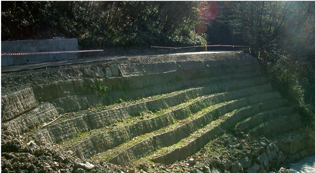
Fig. 97 – Stabilizzazione di fenomeno franoso tramite l'utilizzo di terre armate. La faccia a vista della terra armata è stata rivestita tramite intervento di rinverdimento (B1c).
