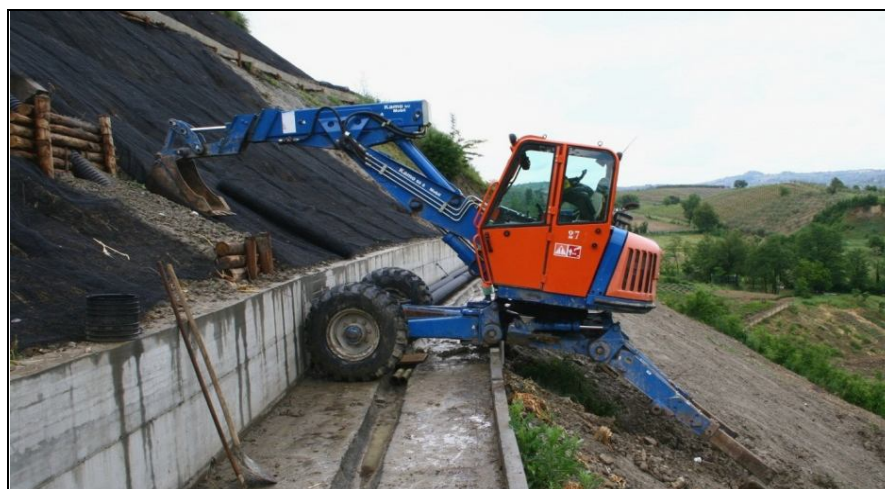
Fig. 12 – Posizionamento di geostuoie, tramite un “ragno” meccanizzato, durante gli interventi di sistemazione di una scarpata. Le geostuoie sono fissate a canalette in cemento armato (B2a) fondate su micropali (D1c) che svolgono una duplice funzione di sostegno.
