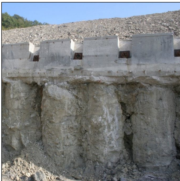
Fig. 76 – A sinistra dettaglio della fase di posa dell’armatura di una palificata di pali di grosso diametro (800mm) durante un intervento di stabilizzazione. A destra dettaglio della porzione superiore di una palificata di pali di grosso diametro, nel quale è visibile la trave tirantata di collegamento in testa dei pali.
