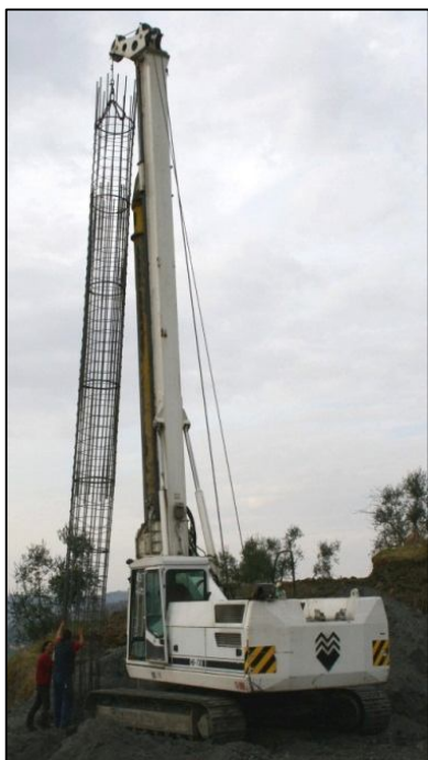
Fig. 76 – A sinistra dettaglio della fase di posa dell’armatura di una palificata di pali di grosso diametro (800mm) durante un intervento di stabilizzazione. A destra dettaglio della porzione superiore di una palificata di pali di grosso diametro, nel quale è visibile la trave tirantata di collegamento in testa dei pali.
