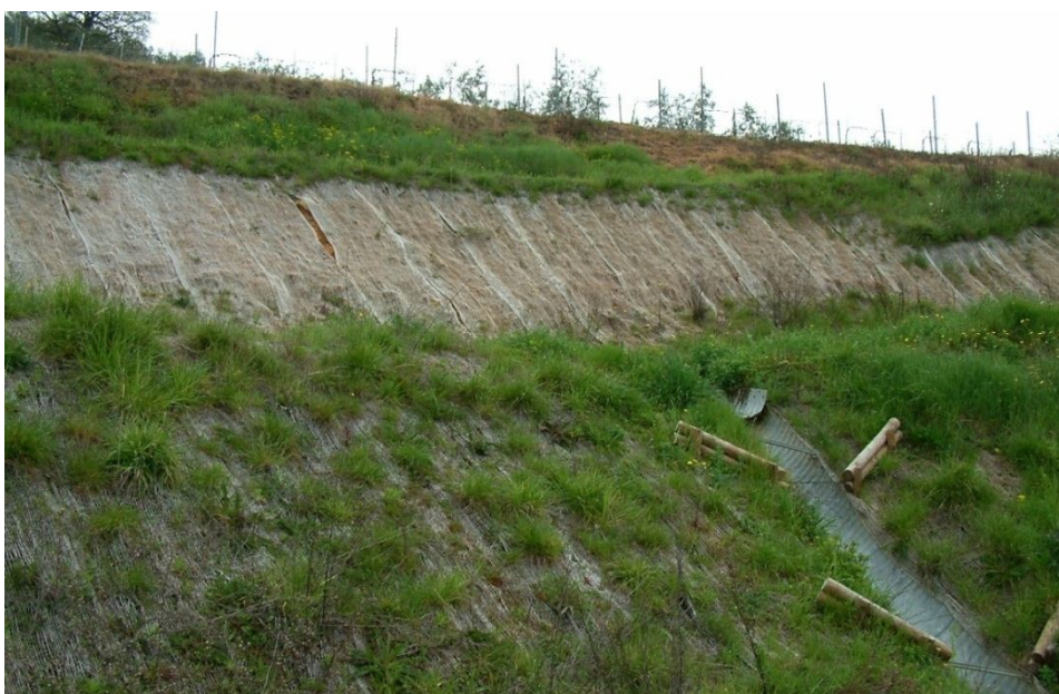
Fig. 15 – Stabilizzazione di un versante tramite rivestimento con biostuoie. Il controllo dell'erosione e la regimazione delle acque superficiali è ottenuta anche per mezzo di canalette prefabbricate in lamiera (intervento B2a) .
