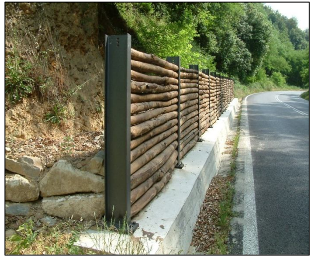
Fig. 124 – A sinistra barriera paramassi rigida in cemento armato sormontata, nei tratti più critici, da una barriera deformabile in pannelli metallici prefabbricati. Nel caso specifico, questo tipo di intervento è accoppiato al rivestimento della parete rocciosa retrostante con rete metallica (da ANPA 2002). A destra barriera rigida, costituita da pannelli in legname incastrati su travi metalliche a doppio T, per il controllo di crolli di materiale detritico in legname.
