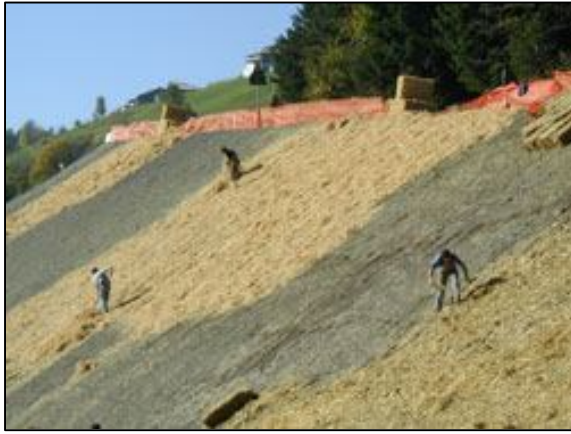
Fig. 16 – Intervento di semina nero-verde su una scarpata: a sinistra distribuzione dello strato di paglia e semina, a destra il risultato dopo tre mesi (immagini tratte dal sito internet www.Vandeborre.it ).
