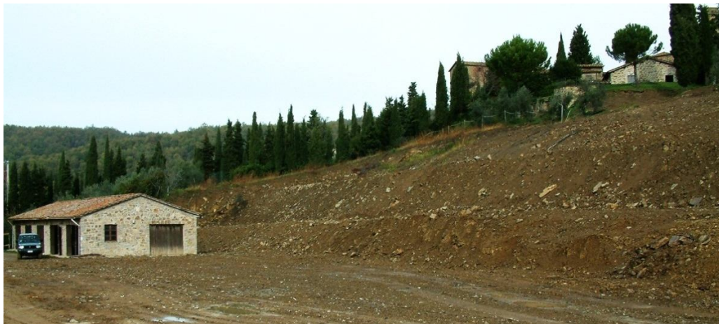
Fig. 8 - Sistemazione di un movimento franoso ottenuto caricando il piede del versante con il materiale scaricato in testa.
