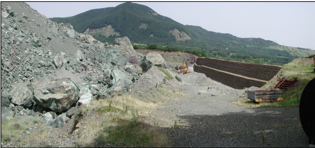
Fig. 125 a – Rilevato paramassi realizzato in corrispondenza del versante orientale del Monte Beni, nel comune di Firenzuola (FI). La struttura di difesa alta 12 m è in grado di assorbire energie di impatto superiori a 10000 kJ; il nucleo centrale e il lato a monte del rilevato sono realizzati in terra rinforzata, mentre il paramento di valle è costituito da semplici strati di terra compattata.
