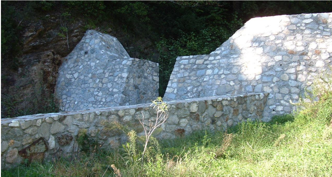
Fig. 118 – Struttura di ritenuta realizzata lungo un impluvio.
