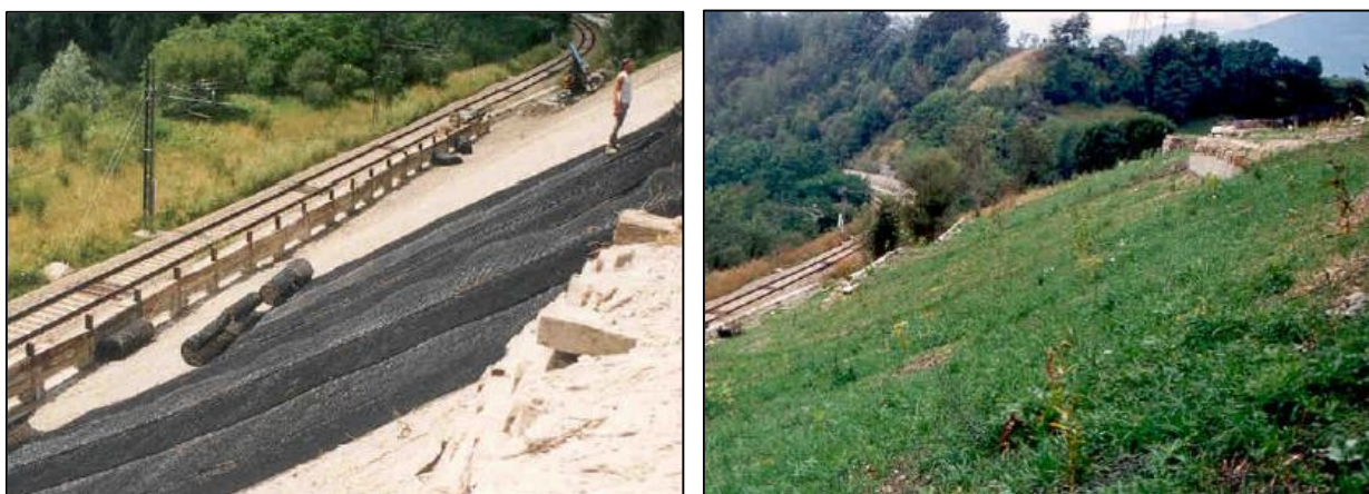
Fig. 11 – Impiego di geostuoia rinforzata con rete metallica, per la stabilizzazione ed il rinverdimento di un versante argilloso: a sinistra fase di posa; a destra situazione dopo l'idrosemina (da ANPA, 2002) .
