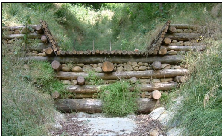
Fig. 110 – Particolare di una briglia in legname e pietrame realizzata nella porzione sommitale di un impluvio.
