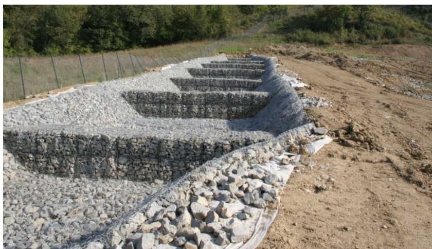
Fig. 38 – Particolare di un fosso di perimetrazione laterale costruito tramite gabbioni e materassi tipo Reno.
