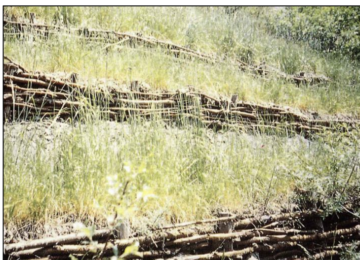
Fig. 26 – Intervento di stabilizzazione di una scarpata tramite graticciate ed inerbimento con specie locali (da REGIONE LIGURIA, 1997).
