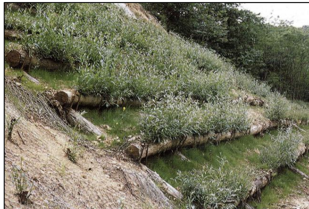
Fig. 32 – In alto rappresentazione schematica di una grata viva. In basso un intervento di stabilizzazione di una frana da scivolamento effettuato tramite la realizzazione di una grata viva: a sinistra particolare della struttura e delle talee di salici; a destra opera a sei mesi dall'ultimazione (da REGIONE LIGURIA, 1997).
