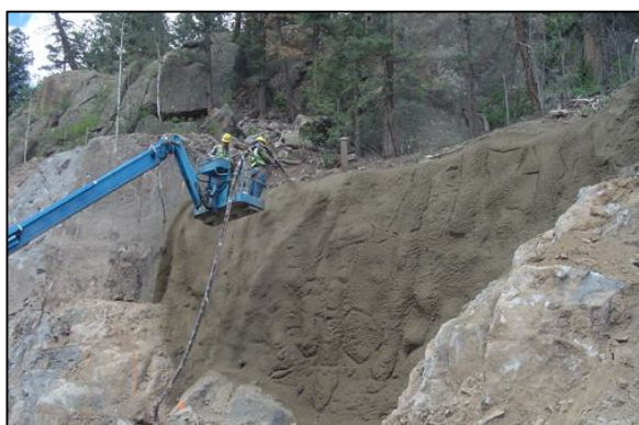
Fig. 95 – Utilizzo di cemento proiettato per la stabilizzazione di pareti rocciose; l'immagine di destra è tratta dal sito internet www.dot.state.co.us (Colorado Department of Transportation), quella di sinistra dal sito www.janod.biz (Janod Inc.).
