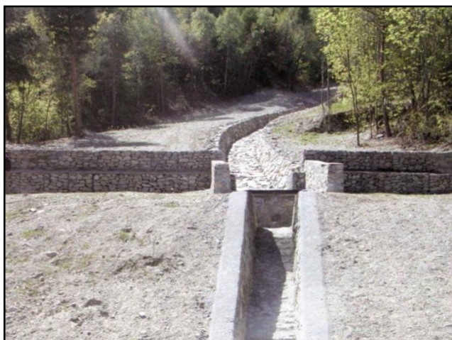
Fig. 114 – Struttura di intercettazione in gabbioni e rete metallica a doppia torsione; al centro il canale rivestito in pietrame che convoglia le portate liquide (da ANPA, 2002).
