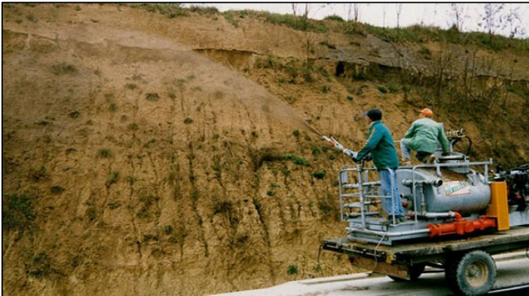
Fig. 17 – Inerbimento di una scarpata tramite idrosemina: l'idroseminatrice è montata su un camioncino ed è munita di lancia girevole, che permette l'aspersione della miscela sulla superficie da trattare (da ANPA, 2002).
